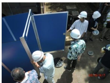
④下水道直結式トイレ組立
