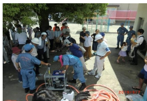
④ 下水道直結式トイレ組立 (送水用ポンプでプールの水を引きこむ)
